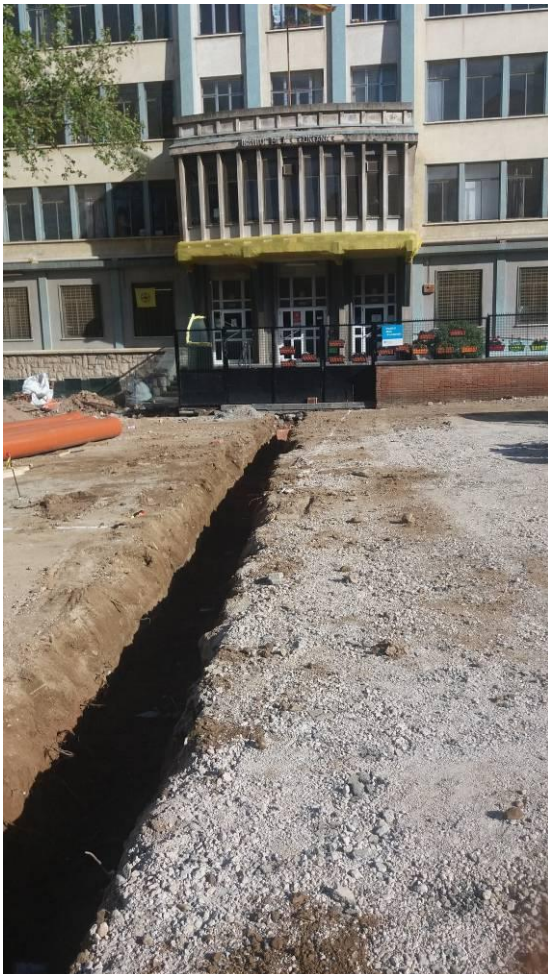
Vista general de la Rasa 6000
