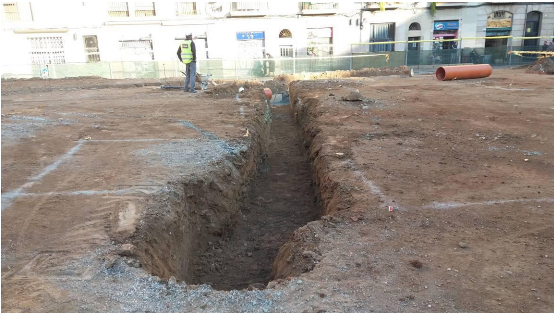
Vista general de la Rasa 8000
