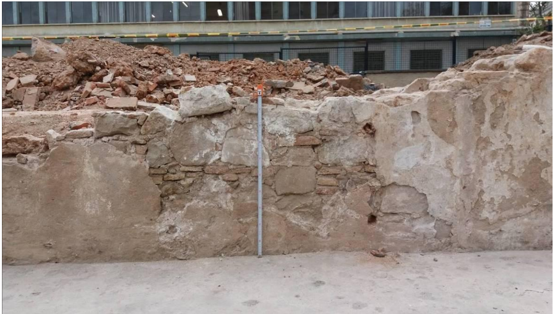
Detall del mur UE 1008
